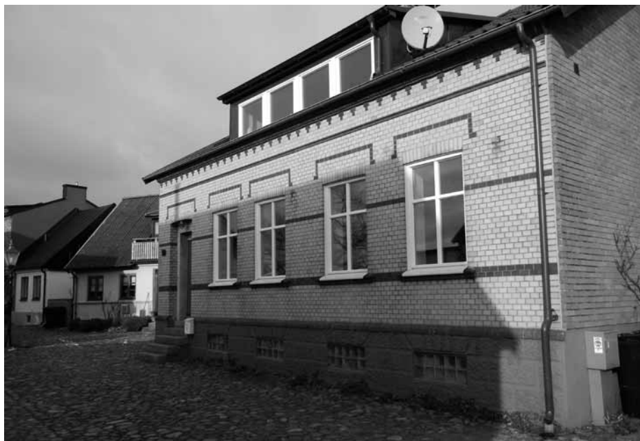
Fiskaregatan 10, troligen det första huset på Råå där förbländertegel pryder fasaden mot gatan.
