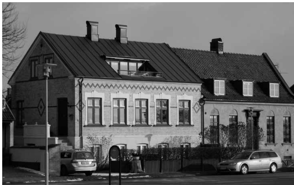
Batteritorget 8 lät Bengt Göransson bygga några år in på 1900-talet. Den stiliga fasaden speglar eftermiddagens sol. Här i källarvåningen startade Blå Boden.
